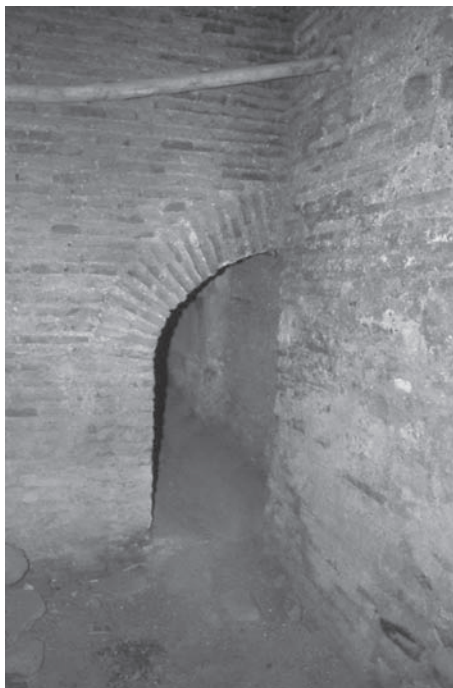
Lám. 3. Entrada al Segundo tramo del primitivo foso del Partal, con la bóveda de cuarto de cañón.
